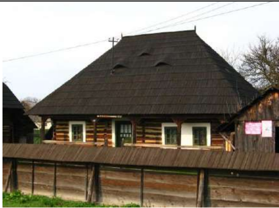
Pokrewieństwo form rzutu budynku i proporcji elewacji, rozkład okien w rytmie 1+2 w zabytkowej chałupie na Bukowinie
