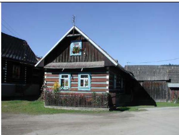
Zbieżny kierunek ewolucji - chałupa asymetryczna w zabudowie zespolonej, kątowej. Dom o zrębie mszonym i malowanym na kolor siwozielony, okna w szczycie, dach o
